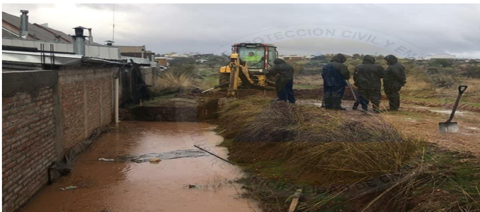
Ilustración 18: Maquinaria Pesada y personal realizando canal de evacuación de agua en Villa Los Acacios.
