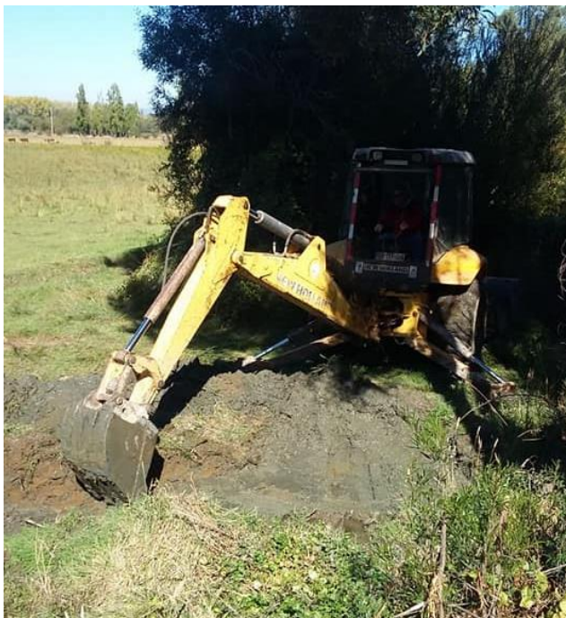
Ilustración 23: Retroexcavadora realizando limpieza de vertiente sector Molco
