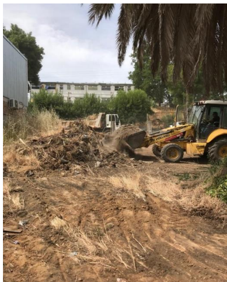
Ilustración 4: Retroexcavadora Unidad de Emergencia retirando pastizales y escombros
