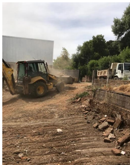
Ilustración 5: Retroexcavadora Unidad de Emergencia retirando pastizales y escombros
