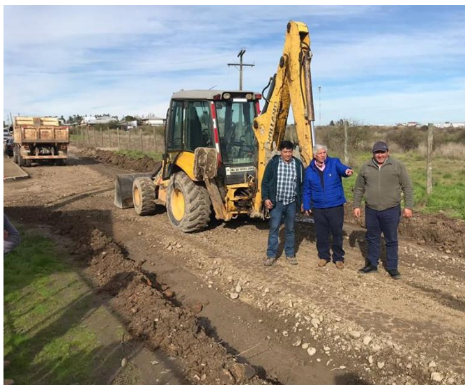
Ilustración 7: Alcalde supervisando trabajos de mejoramiento de calzada
