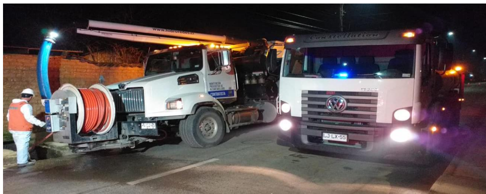
Ilustración 6: Camión Hidrojet de empresa Contratista de Nuevo Sur efectuando limpieza de canal de evacuación de agua lluvia, apoyado directamente de camión aljibe Municipal
