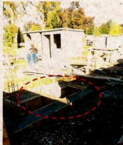
Fotografía N° 11 – 04/04/18: Tumba en construcción abandonada en sector "ampliación" del Cementerio Municipal de Cauquenes, sin la debida protección de su excavación.
