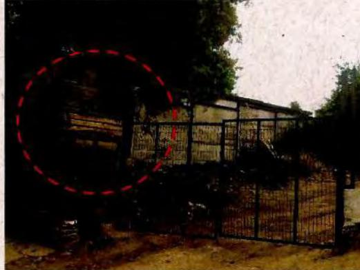
Fotografía N° 5 – 05/04/18: Cerramiento de madera provisorio en cierre perimetral en el encuentro de los deslindes norte y poniente del establecimiento.
