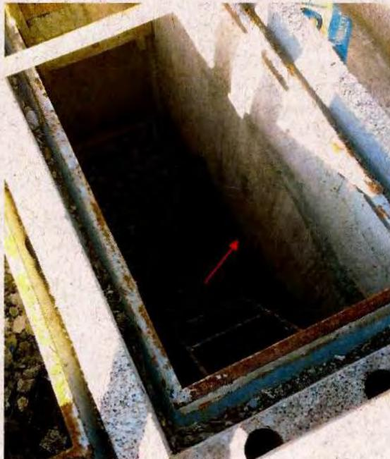
Fotografía N° 9 – 05/04/18: Vista interior sepultura del proyecto de "Ampliación Cementerio Municipal" donde se aprecia los restos de humedad producto de su inundación
