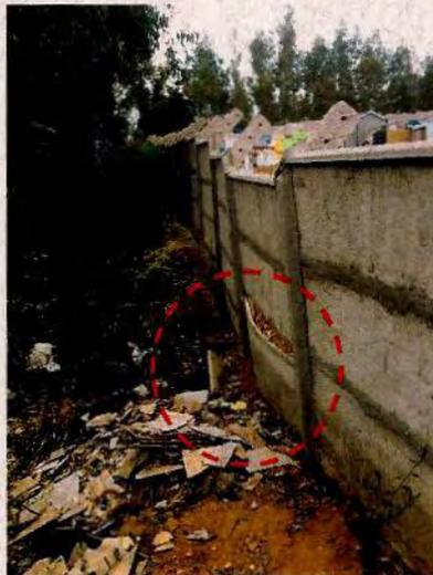
Fotografía N° 7 – 04/04/18: Vista exterior de cerco perimetral de deslinde poniente en deficiente estado en camposanto "Coronel de Maule".
