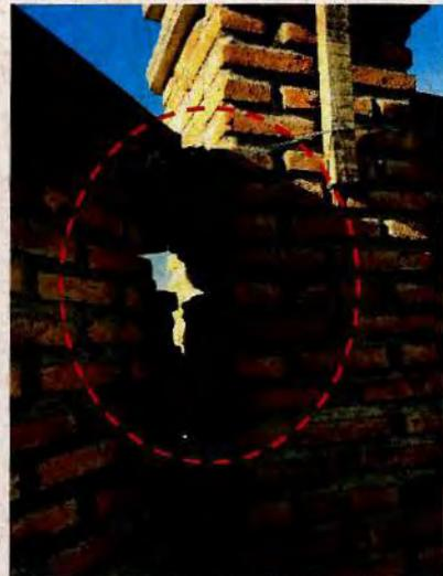
Fotografía N° 4 – 05/04/18: Detalle interior de ruptura en unión de pilar y muro de cierre perimetral en tramo de deslinde sur del sector "Parque" del establecimiento.
