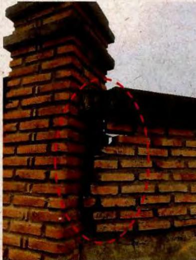
Fotografía N° 3 – 05/04/18: Vista exterior de ruptura en unión de pilar y muro de cierre perimetral en tramo de deslinde suroriente del sector "Parque" del establecimiento.
