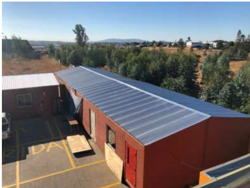
Reparación de techumbre CESFAM Ricardo Valdés
