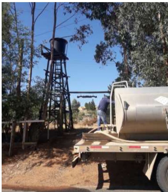
CAMION ALJIBE MUNICIPAL ABASTECIENDO COMITE DE AGUA "POBLACION LOYOLA" POSTERIOR TEMPORAL DE VIENTO Y LLUVIA
