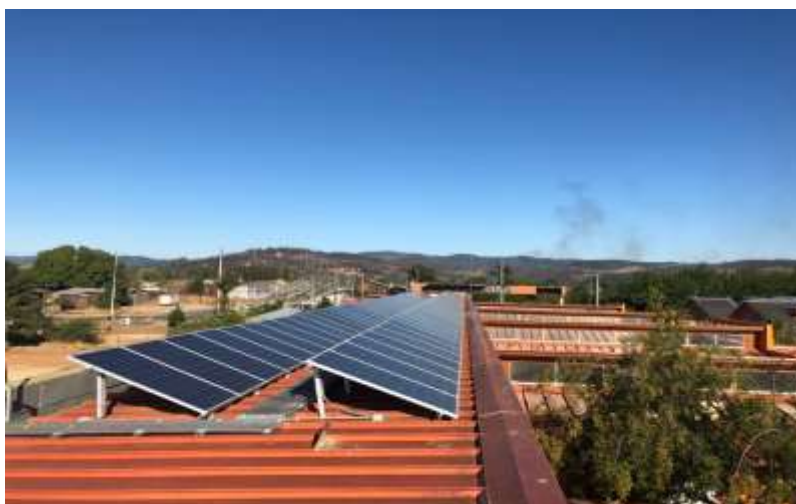
Habilitación de paneles solares en el CESFAM Ricardo Valdés.
