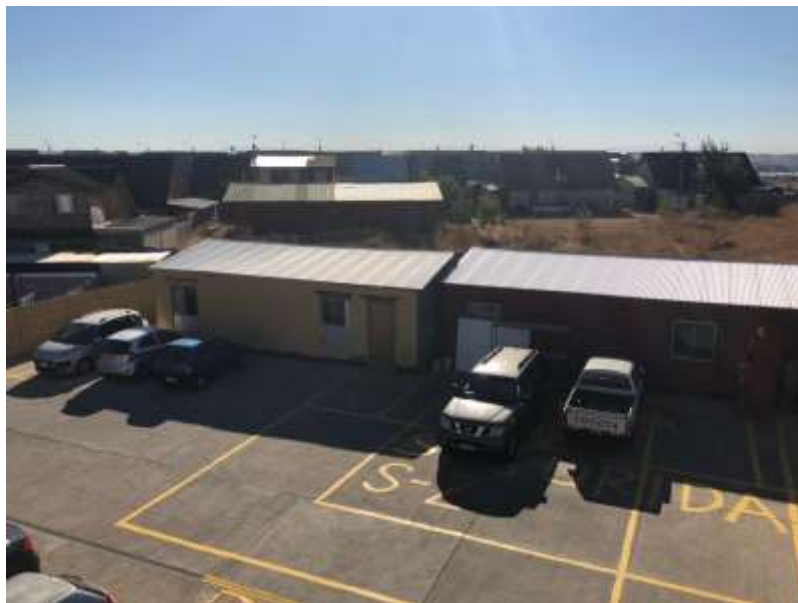
Instalación y habilitación módulos en el CECOSF Los Conquistadores
