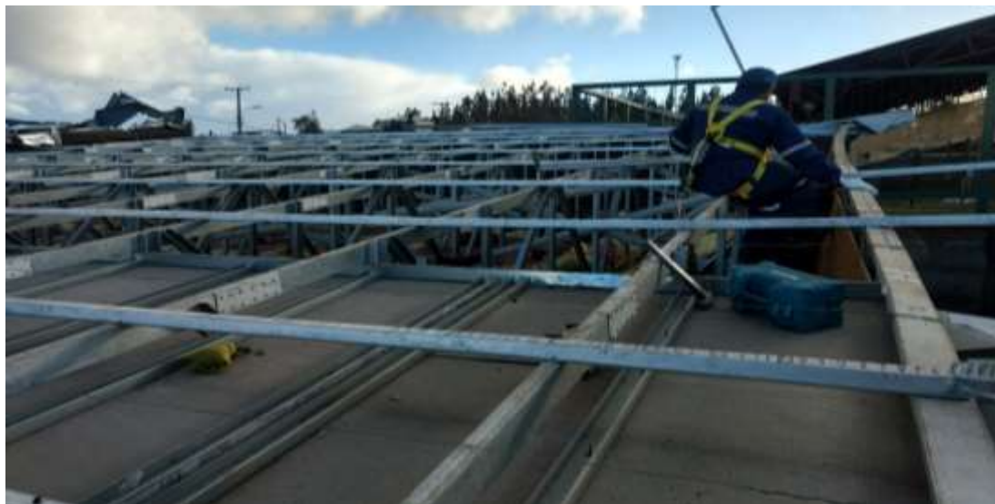
Arreglos en Techumbre Cecof Rosita O'Higgins
