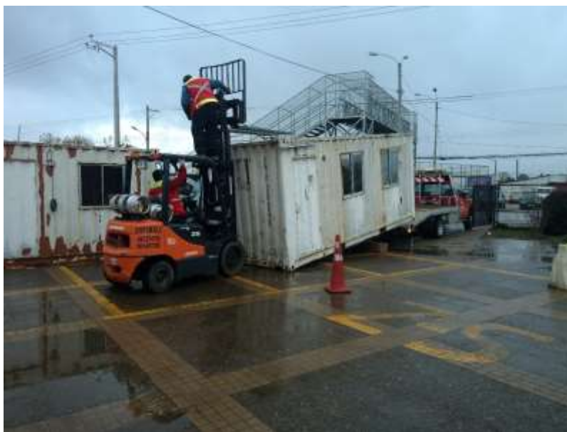
Instalación y habilitación módulos en el CECOSF Los Conquistadores
