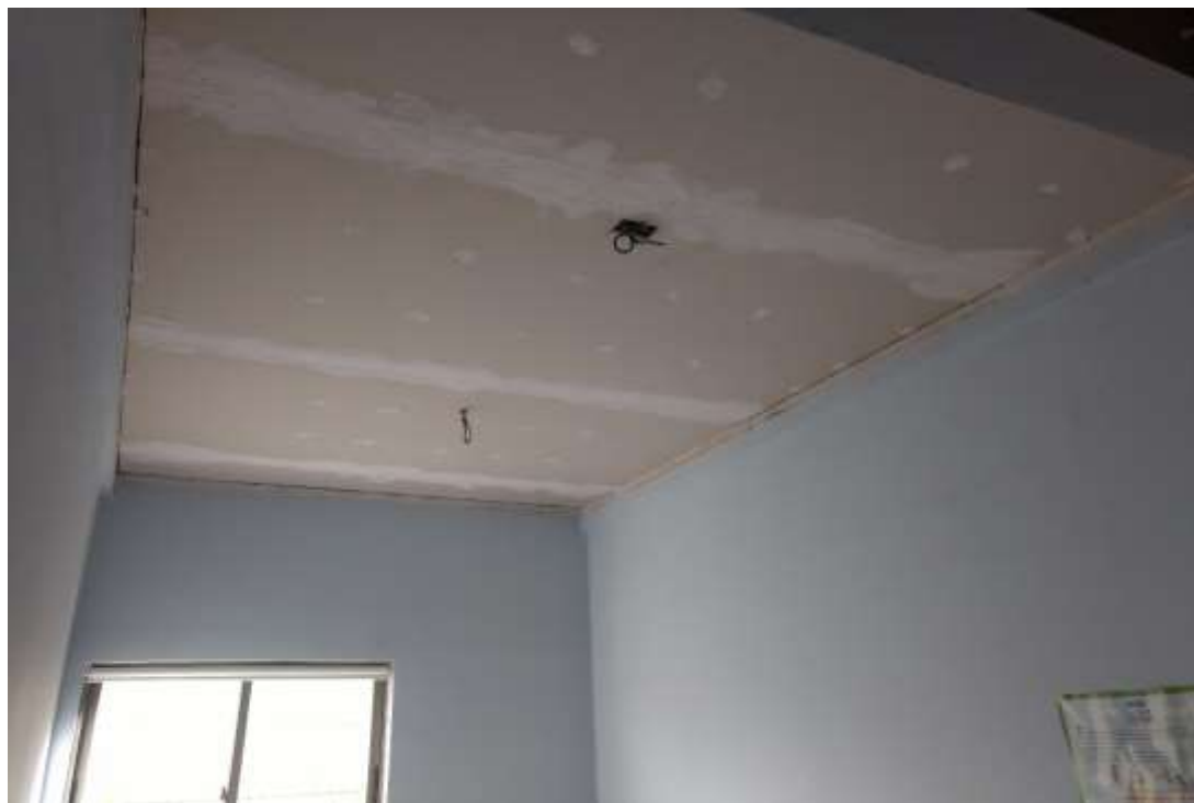
Arreglos en Cielo Interior Cecof Rosita O'Higgins
