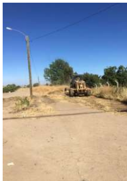
Motoniveladora Municipal realizando confección de Cortafuegos
