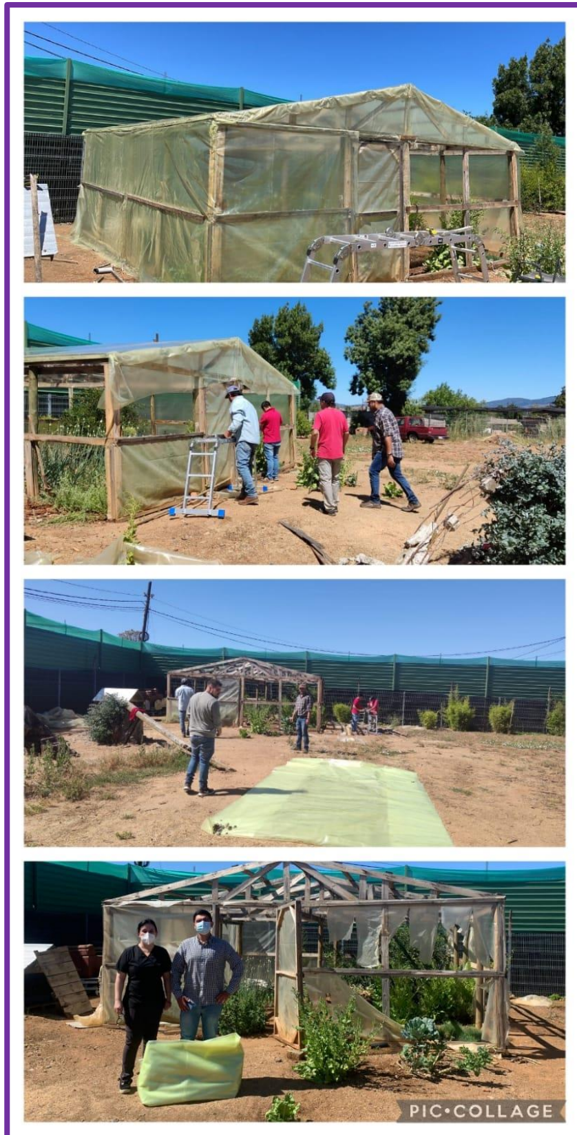
IMAGEN 17: REPARACION INVERNADERO ESTABLECIMIENTO DE LARGA ESTADIA ADULTO MAYOR (ELEM) CAUQUENES.
