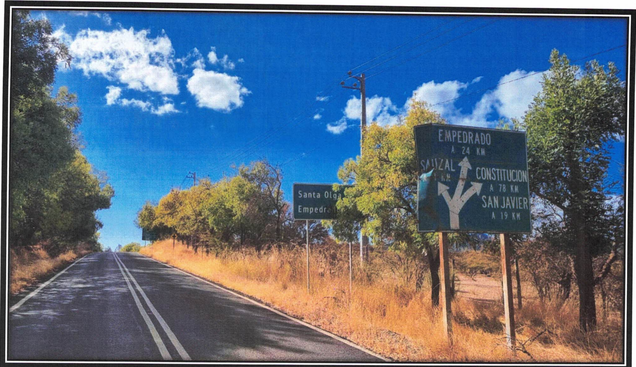
Entrada que no se visualiza por el mal mantenimiento generando desconcierto al conductor y evita que los viajeros no ingresen a Sauzal.
